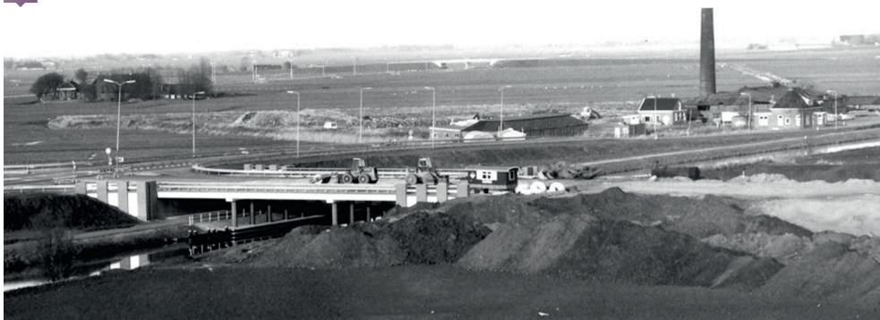
17 STEENFABRIEK EUREKA, OP DE VOORGROND DE BEIJUMBRUG IN AANBOUW
